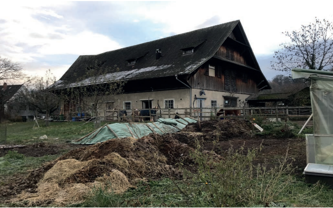
Ansicht Nordwest und Südwest
