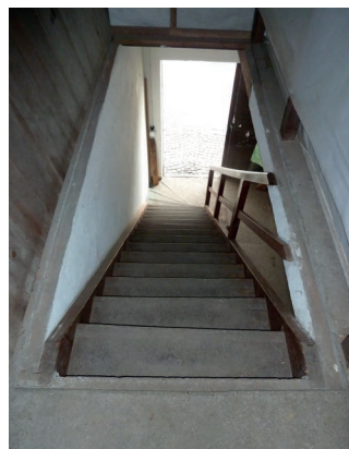
Treppe 1.OG-EG (Mostraum)
